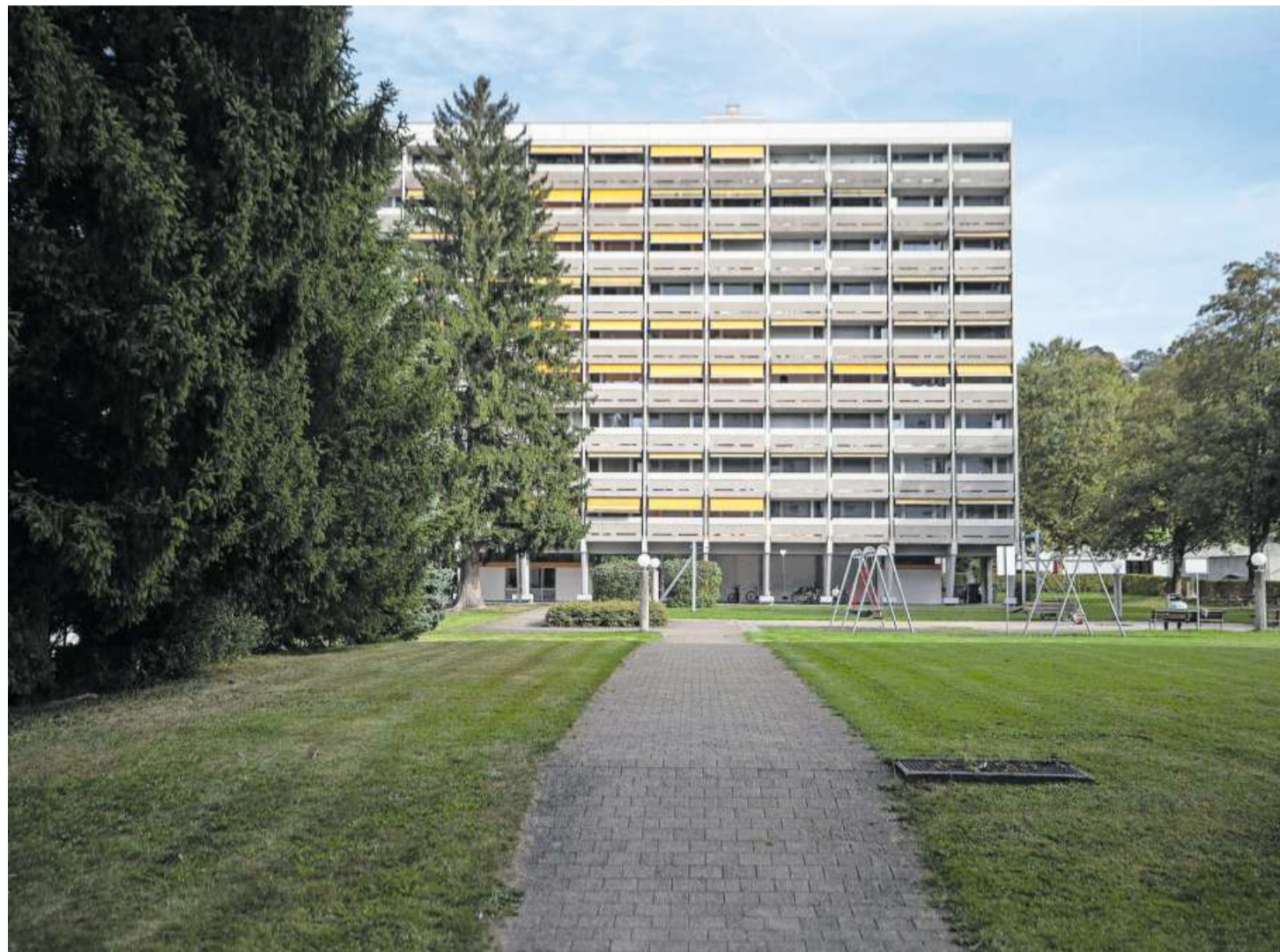
Wird nicht saniert, sondern abgerissen: Ein Scheibenhäuser in Inwil bei Baar.
