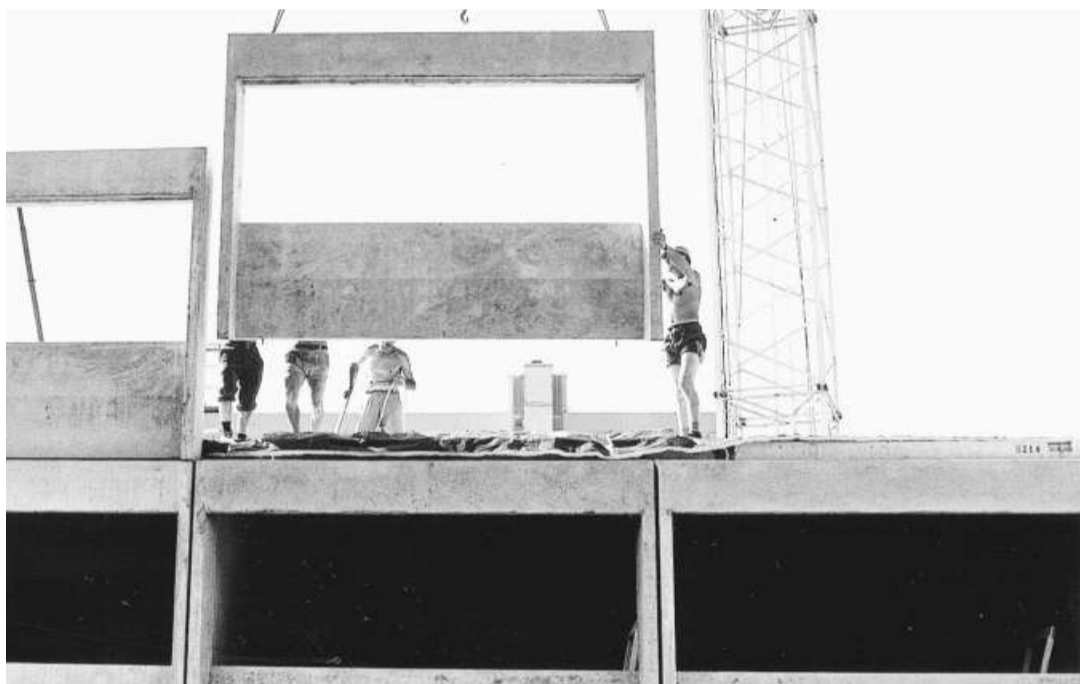
Wie Legosteine: Das Fassadenelement einer Scheibe wird montiert, um 1968.
