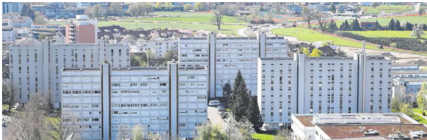
Fest steht, dass die Hochhäuser in Inwil abgerissen werden, noch offen ist, was an ihrer Stelle gebaut wird.
