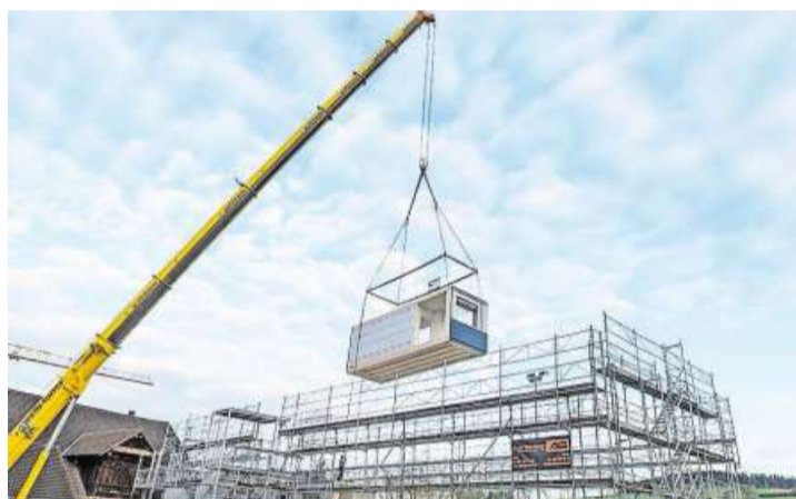
Die Schule Sennweid wird in modularer Bauweise erweitert.
