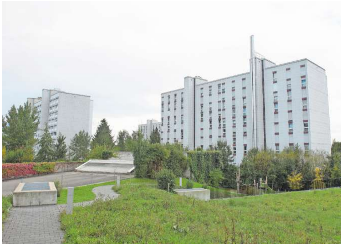
Die Scheibenhäuser entstanden in den 1960-er Jahren.
